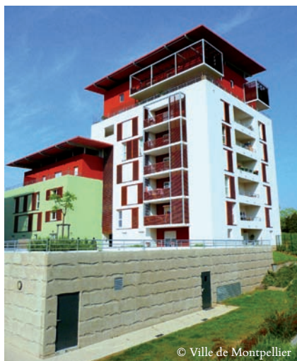
La résidence Françoise Sagan dans le quartier des Jardins de la Lironde accueille 69 logements sociaux. (Architecte F. Fontès).
